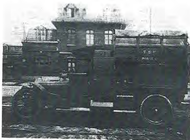
Poste Marconi 1/2 Kw sur automobile Sheffield-Simplex vers 1922
